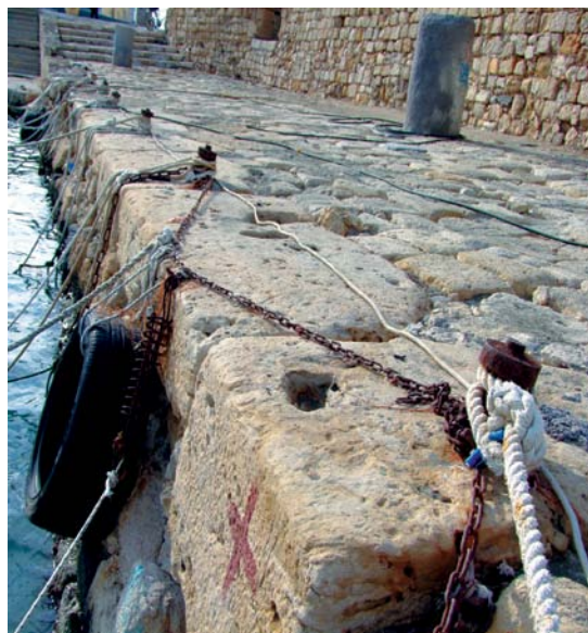
Εικ. 3. Τμήμα του βόρειου βραχίονα με μεγάλους γωνιόλιθους δεύτερης ή τρίτης χρήσης.
