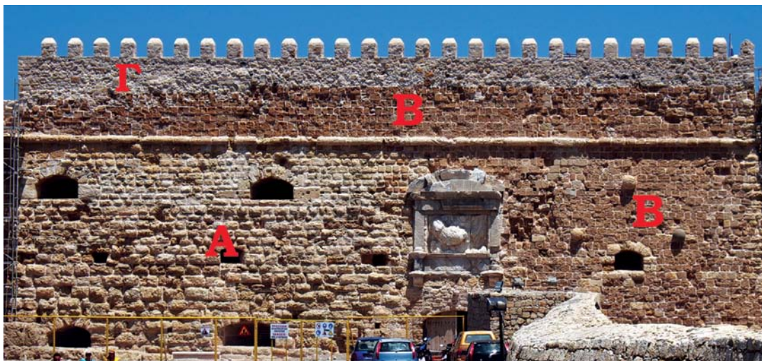
Εικ. 14. Η δυτική πλευρά με εμφανή τα τρία είδη πετρωμάτων. Α: μεγάλοι πλάτους (πάνω από 40 εκατοστά), ανοιχτόχρωμοι, μαργαίκοι ασβεστόλιθοι από δεύτερη (ή τρίτη) χρήση. Β: σκουρόχρωμοι (καφέ-κόκκινοι) ψαμμίτες πλάτους κάτω από 35 εκατοστά, με προέλευση το παράκτιο τμήμα δυτικά κυρίως του λιμανιού. Γ: χωρίς σαφή κριτήρια μικρού πλάτους μαργαίκοι ασβεστόλιθοι, ψαμμίτες, κ.λπ.
