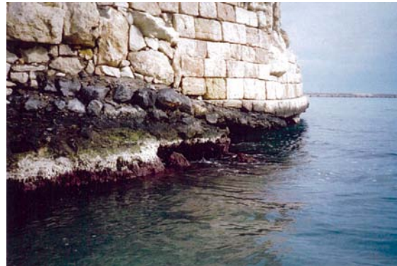
Εικ. 6. Η σπηλαίωση στο ΝΑ άκρο το 2003 αποκάλυψε τον μαύρο ασβεστόλιθο Γαβρόβου – Τριπόλεως στρωμένο και πάνω του εδράζεται το φρούριο. Φωτογραφία Ο.Α.Η., 2003.
