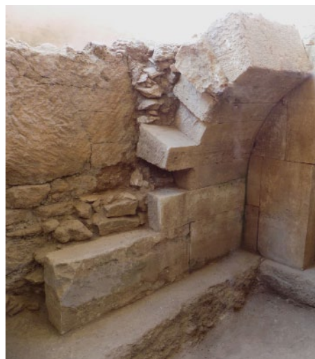
Εικ. 5. Άποψη της καμάρας – νότιο τοίχωμα.
