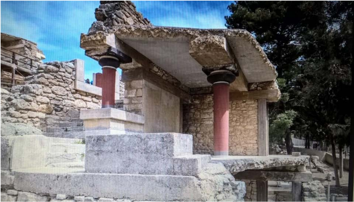
Εικ. 13. Γήρανση σπλισμένου σκυροδέματος στην Κνωσό.
