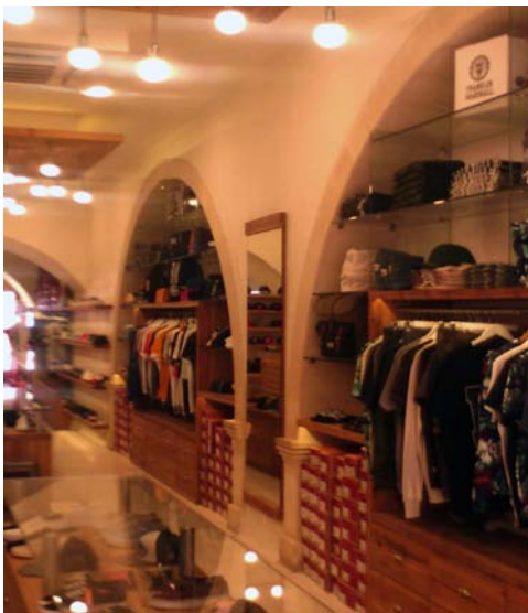
Εικ. 16. Κτήριο επί της Αρκαδίου 153-155 και Ελ. Βενιζέλου 45α: εγκάρσια και διαμήκη τόξα στις φέρουσες τοιχοποιίες βενετικής περιόδου.
