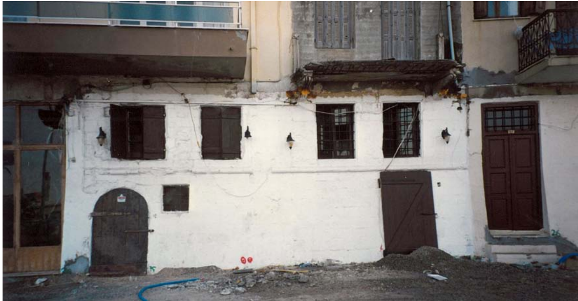
Εικ. 5. Διαγωνιαίο κτήριο επί των οδών Αρκαδίου, Καλλέργη και Ελ. Βενιζέλου: ισόγειο αυθεντικό τμήμα με scarpa και cordone .
