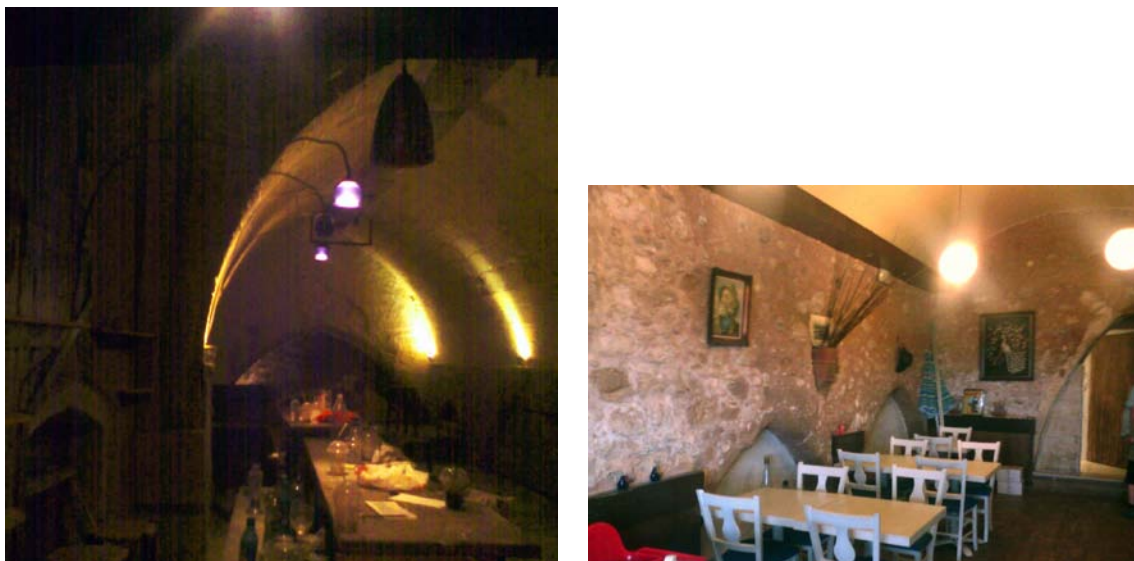
Εικ. 13. Κτήριο βενετικής εκκλησιαστικής αρχιτεκτονικής με οξυκόρυφα τόξα που εμφανίζονται και στο συνεχόμενο κτήριο προς βορρά. Διακρίνεται μόνο το άνω τμήμα τους, ενώ το κάτω έχει επιχωθεί σε ύψος τουλάχιστον 1,50 μ.
