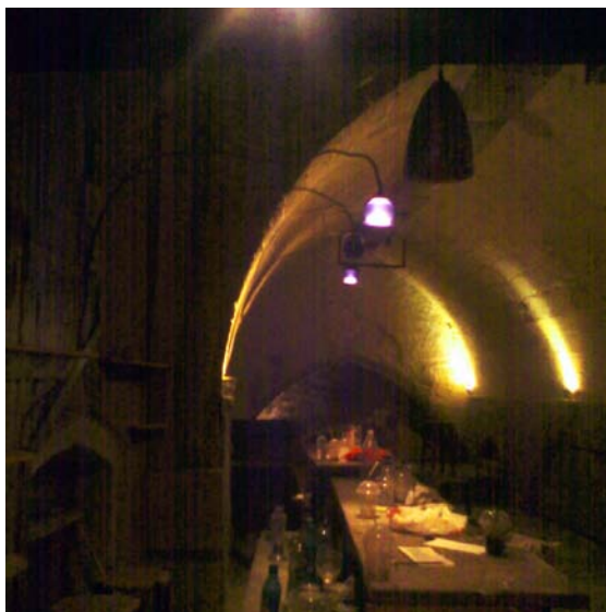
Εικ. 13. Κτήριο βενετικής εκκλησιαστικής αρχιτεκτονικής με οξυκόρυφα τόξα που εμφανίζονται και στο συνεχόμενο κτήριο προς βορρά. Διακρίνεται μόνο το άνω τμήμα τους, ενώ το κάτω έχει επιχωθεί σε ύψος τουλάχιστον 1,50 μ.
