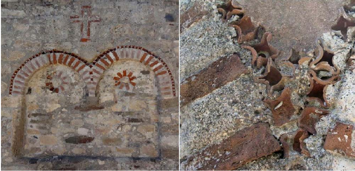
Εικ. 20. Λεπτομέρειες διακοσμητικών στοιχείων στην τοιχοποιία του ναού στην Κάτω Επισκοπή Σητείας και στον τρούλο της Επισκοπής Ιεράπετρας (φωτογραφίες: Α. Τάντσης).
