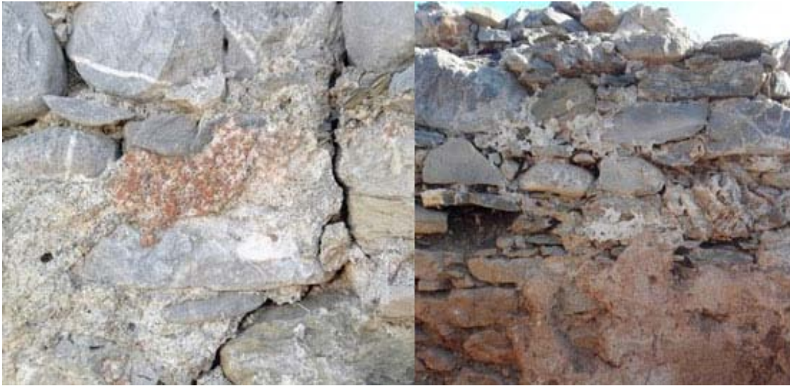
Εικ. 6. Λεπτομέρειες υδραυλικών κονιαμάτων από την εξωτερική και την εσωτερική επιφάνεια του κτηρίου Β (φωτογραφία: Α. Τάντσης).
