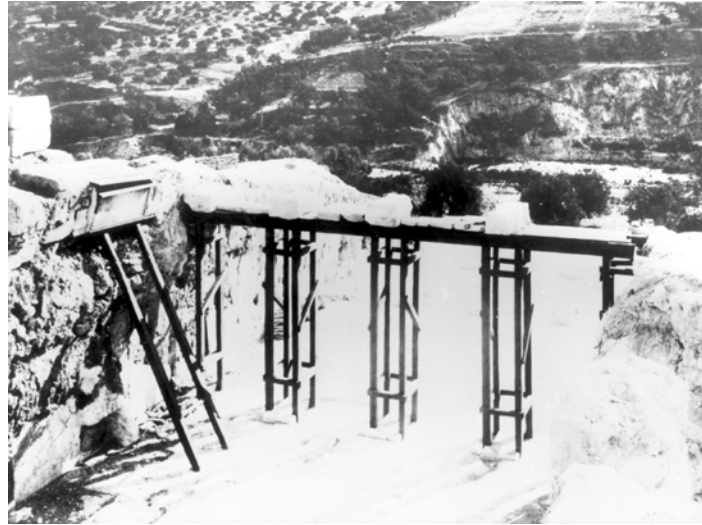
Εικ. 10. Ανάκτορο Κνωσού, «Αίθουσα των Διπλών Πελέκεων». Διακρίνονται τα ξύλινα υποστυλώματα πάνω στις λίθινες βάσεις ενίσχυσης της αναστηλωμένης τοιχοδομίας.
