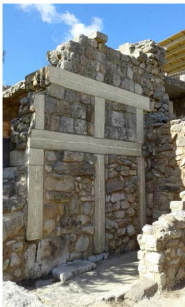
Εικ. 4. Ανάκτορο Κνωσού, χώρος των Εργαστηρίων. Αποκατάσταση του ξύλινου συστήματος ενίσχυσης της αναστηλωμένης τοιχοδομίας.
