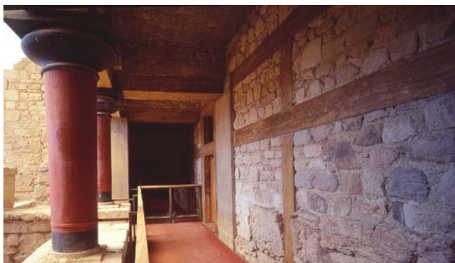
Εικ. 5. Ανάκτορο Κνωσού, «Ανατολικός – Δυτικός Διάδρομος». Αποκατάσταση του ξύλινου συστήματος ενίσχυσης της αναστηλωμένης τοιχοδομίας.
