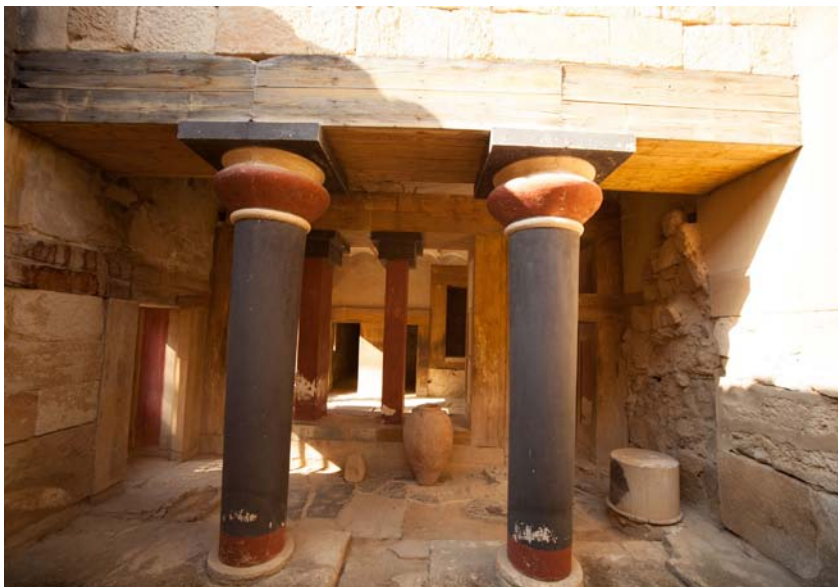
Εικ. 9. Ανάκτορο Κνωσού, «Μέγαρο Βασίλισσας». Αποκατάσταση του ξύλινου συστήματος ενίσχυσης της αναστηλωμένης τοιχοδομίας.
