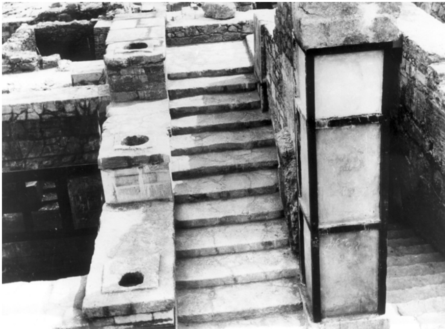
Εικ. 14. Ανάκτορο Κνωσού, «Μεγάλο Κλιμακοστάσιο», 1905. Διακρίνεται η πρώτη αποκατάσταση πεσσού.
