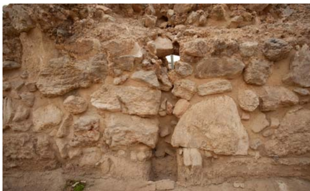
Εικ. 7. Ανάκτορο Κνωσού, «Δυτικές Αποθήκες III-VII». Διακρίνεται η εγκοπή τοποθέτησης του ξύλου, μετά την αφαίρεση της παλαιάς σφράγισης.
