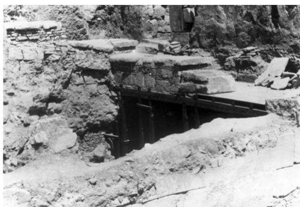
Εικ. 3. Ανάκτορο Κνωσού, ξύλινα υποστυλώματα στον «Ανατολικό – Δυτικό Διάδρομο».
