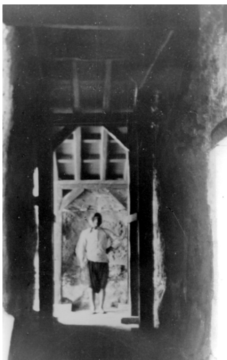
Εικ. 2. Ανάκτορο Κνωσού, «Ανατολικός – Δυτικός Διάδρομος». Αποκατάσταση του ξύλινου συστήματος ενίσχυσης της αναστηλωμένης τοιχοδομίας.
