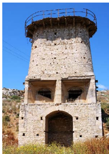
Εικ. 13. Το κατακόρυφο συγκρότημα σκυροθραυστών στην περιοχή του λατομείου Ξηροποτάμου, λήψη από Α. Προέλευση φωτογραφίας: Στέλιος Μανωλιούδης.
