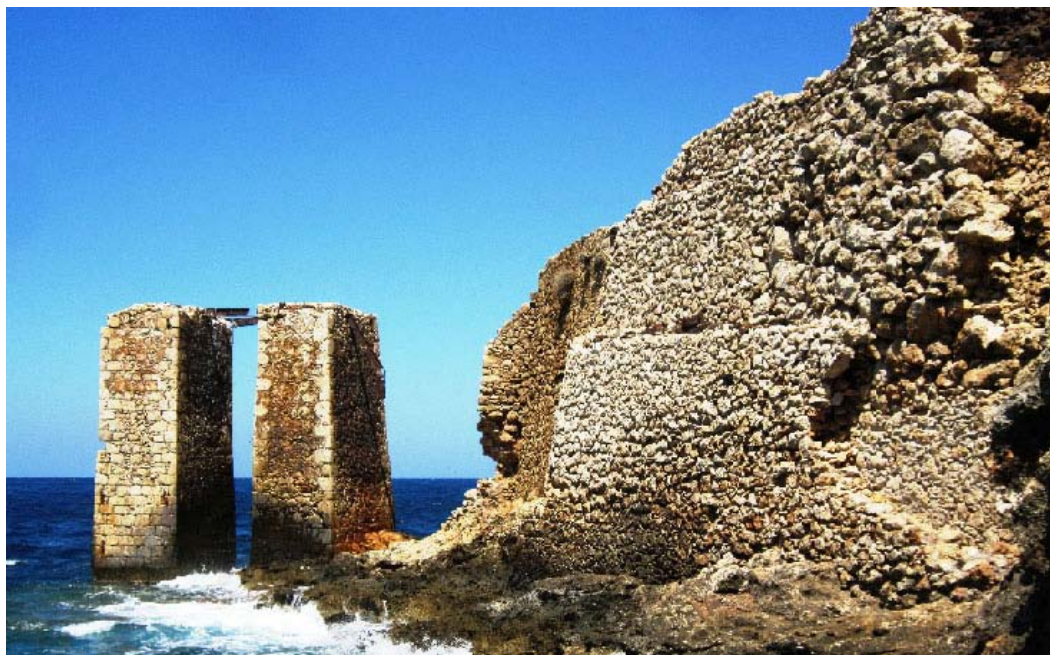
Εικ. 18. Δίδυμα λιθόκτιστα βάθρα γέφυρας φόρτωσης μεταλλεύματος στο μεταλλευτικό πεδίο Ραβδούχας. Προέλευση φωτογραφίας: Πολύκαρπος Τζίκας.
