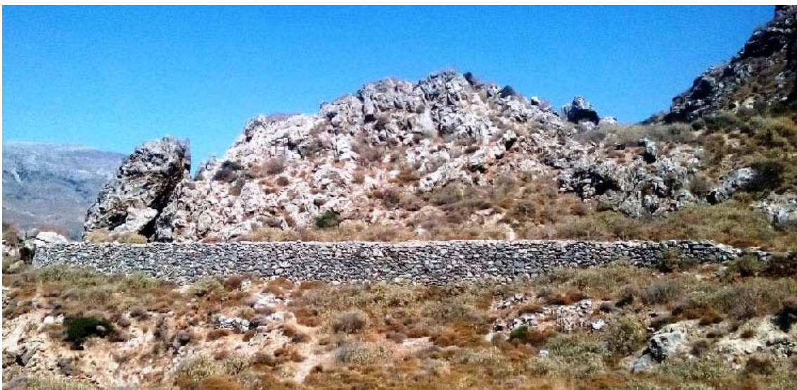
Εικ. 15. Ξερολιθικό άνδηρο της υποδομής του βιομηχανικού σιδηροδρομικού δικτύου Πλακιά. Προέλευση φωτογραφίας: Ευάγγελος Χαριτόπουλος.
