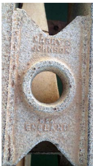
Εικ. 12. Τμήμα της μεταλλικής υπερκατασκευής της γέφυρας στον ποταμό Γιόφυρο, όπου αναγράφεται η ονομασία της εταιρείας MABEY & JOHNSON, ENGLAND . Προέλευση φωτογραφίας: Ευάγγελος Χαριτόπουλος.
