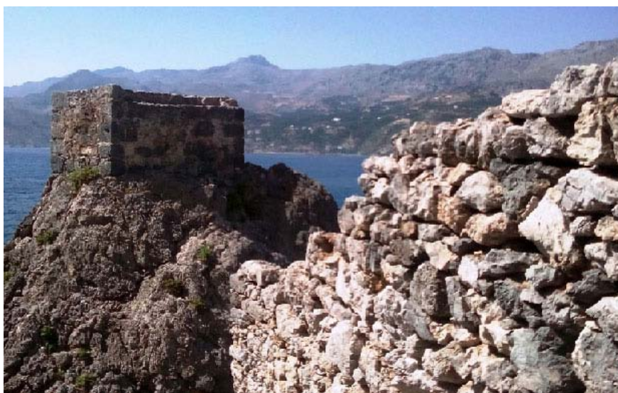
Εικ. 17. Λιθόκτιστο βάθρο γέφυρας φόρτωσης μεταλλεύματος στον Πλακιά. Προέλευση φωτογραφίας: Ευάγγελος Χαριτόπουλος.
