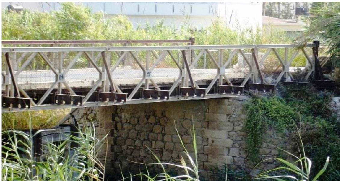
Εικ. 11. Το δυτικό τμήμα της γέφυρας στον ποταμό Γιόφυρο με τα λιθόκτιστα βάθρα και τη μεταλλική υπερκατασκευή. Προέλευση φωτογραφίας: Ευάγγελος Χαριτόπουλος.
