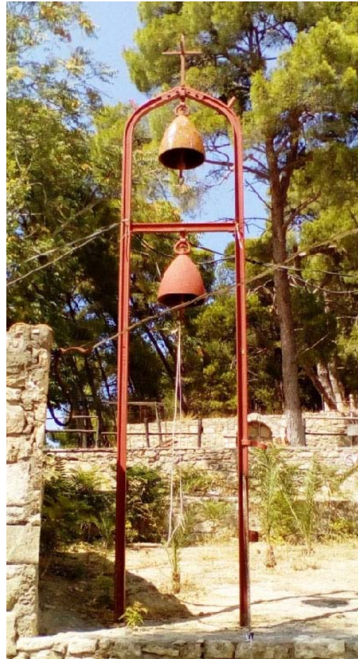
Εικ. 19. Κωδωνοστάσιο στον ναό της Αγίας Ειρήνης στα Σπήλια, με επανάχρηση σιδηροτροχιών τύπου decauville. Προέλευση φωτογραφίας: Ευάγγελος Χαριτόπουλος.
