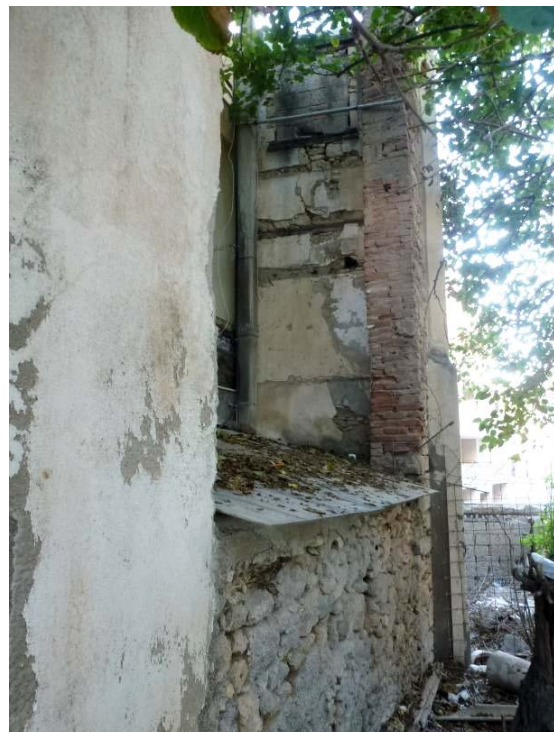
Εικ. 13. Σωζόμενα οικοδομικά στοιχεία του κατεδαφισμένου τμήματος. Αριστερά, εσωτερικός τοίχος προς το διατηρούμενο και ξυλοδεσιές στον νότιο. Δεξιά, νοτιοανατολική γωνία.
