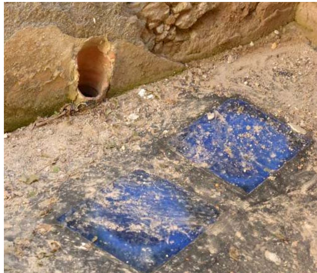
Εικ. 9. Οι αεραγωγοί και τα φωτιστικά ανοίγματα του θόλου.
