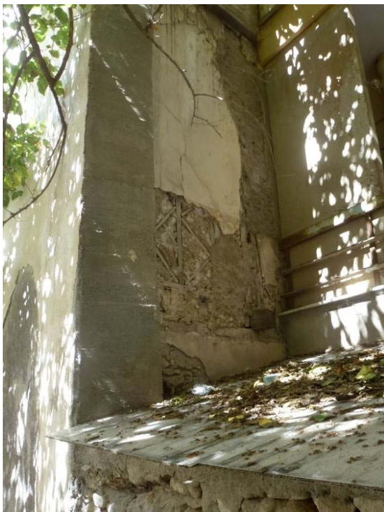
Εικ. 13. Σωζόμενα οικοδομικά στοιχεία του κατεδαφισμένου τμήματος. Αριστερά, εσωτερικός τοίχος προς το διατηρούμενο και ξυλοδεσιές στον νότιο. Δεξιά, νοτιοανατολική γωνία.
